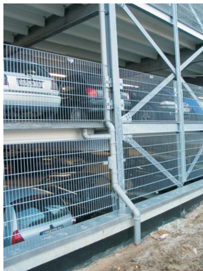
Das Rohrsystem nach der Fertigstellung des Parkhauses mit zusätzlichem Deckanstrich.
